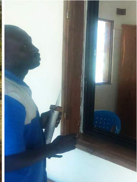
pose de fenêtres
