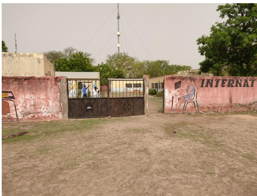
Au retour visite à l'internat du lycée de Bala bien dégradé
